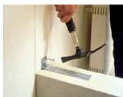
Ogni 2/3 file ancorare i blocchi alla struttura. Le pareti in blocchi devono essere ammorsate tra loro per aumentare la stabilità del muro.
